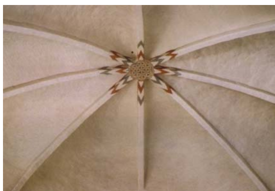
Fig. 4.10 Underside af ribbehvælv
