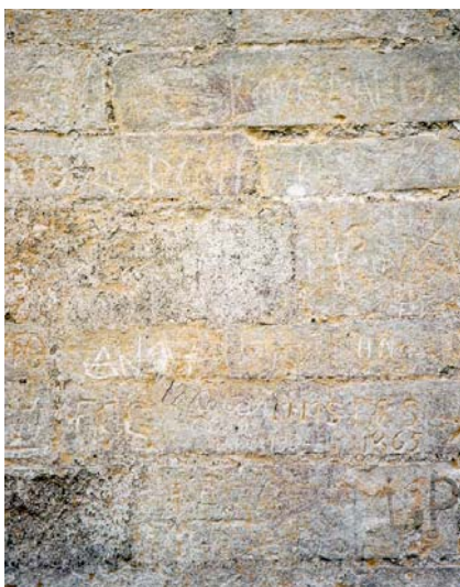
Fig. 3.5 Murværk af kridtsten. Som det ses er kridtsten bløde, så de kan ridses.
