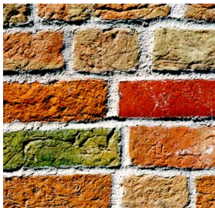
Fig. 3.1 Renoveret murværk i munkesten
