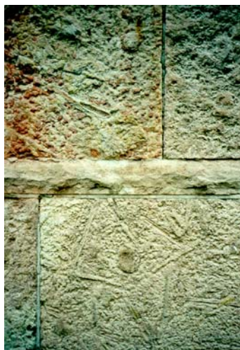
Fig. 3.4 Afrensede ca. 100 år gamle kalkstensplader på ydervæg
