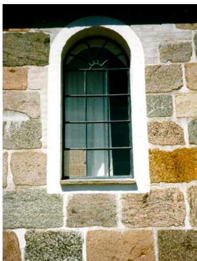
Fig. 3.2 Murværk af granitsten i kirke i Vendsyssel
